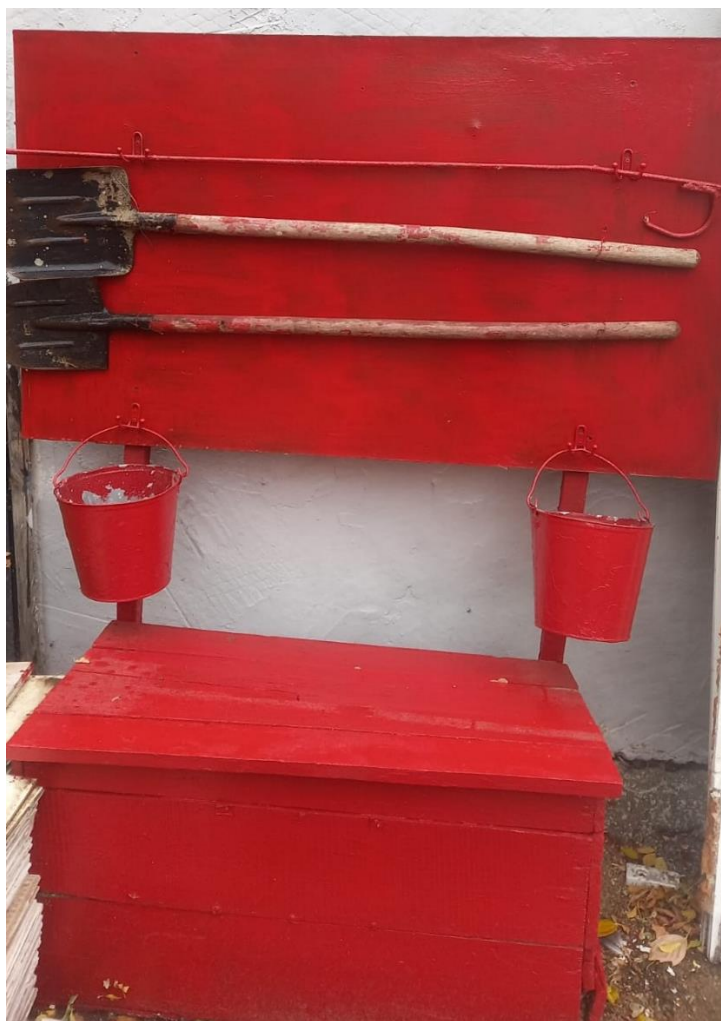
Открытый пожарный щит с ящиком для песка и инвентарем (ведрами, лопатами и багром).
